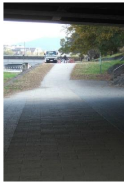
橋の下の上りスロープ
